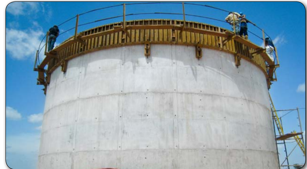
La cara completamente de acero de los paneles REDI-RADIUS entrega una superficie de concreto arquitectónico lisa y uniforme.
