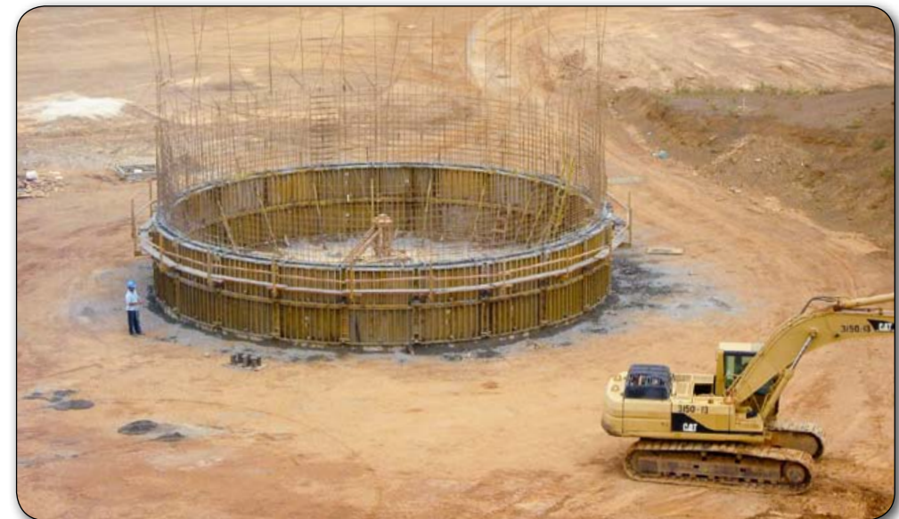
El sistema de encofrado REDI-RADIUS de EFCO está diseñado para encofrar muros de radios fijos o variables con diámetros de 3.0 metros o mayores.
